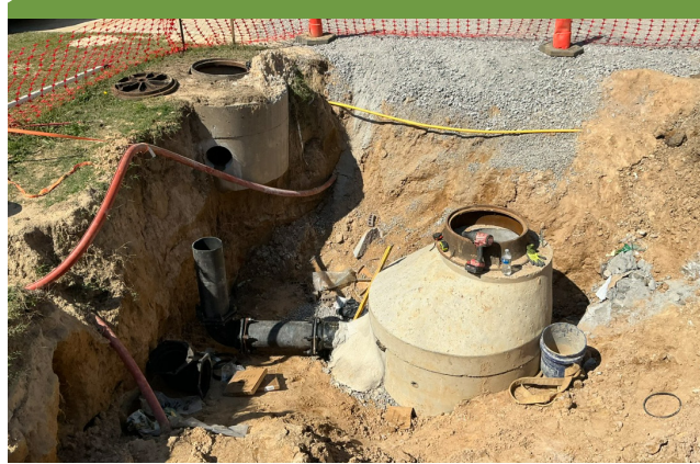
3 Mars Hill Gravity Sewer
